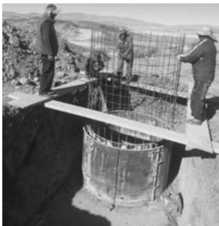
2x2 Meter ausgehoben werden musste. Durch die jüngsten Regenfälle füllte sich die Grube immer wieder mit Wasser und die Seitenwände waren wegen der Regenfälle so instabil, dass die Seitenwände verstärkt werden mußten.
